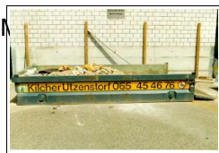
4m 3 Flachmulde befahrbar (4100x2130x420)
